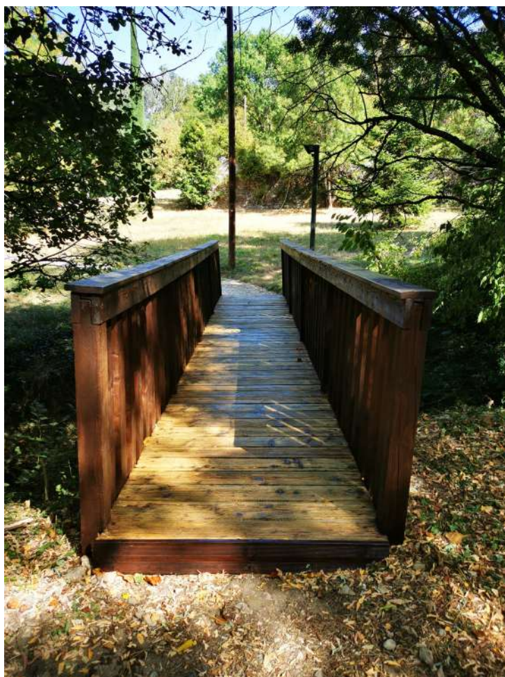
Le pont ! ...oui, c'est par ici !!
